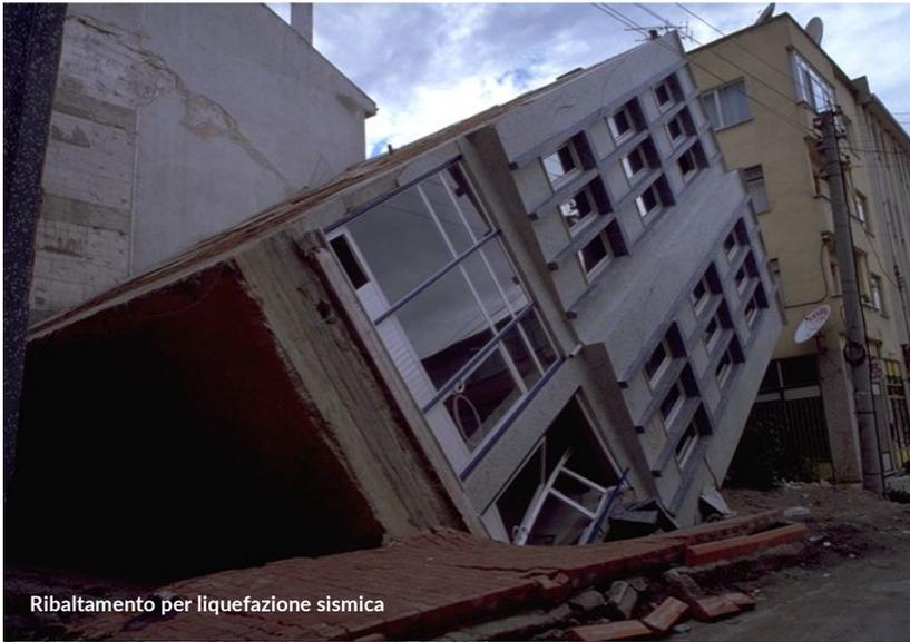
Ribaltamento per liquefazione sismica
